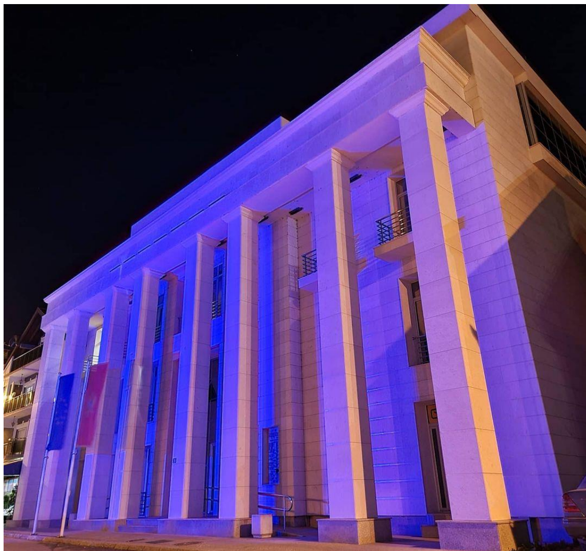
Slika 2: Zgrada opštine Gusinje
